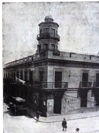
El histórico edificio que ocupó el Banco hasta hace poco, situado en las calles Rincón esq. Misiones.
