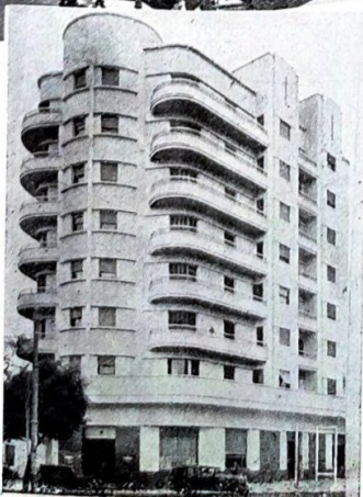
Edificio Av. Agraciada
