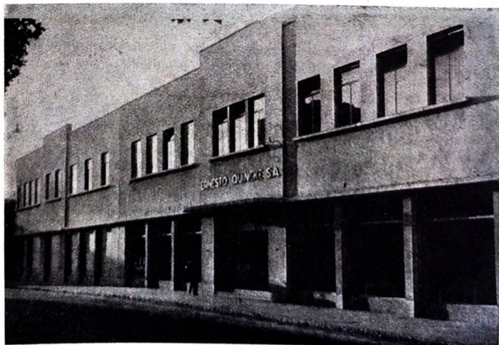
Fachada de la casa central en las calles Cerro Largo y Andes
