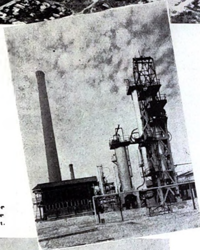
Unidad de Cracking de la Refinería.
