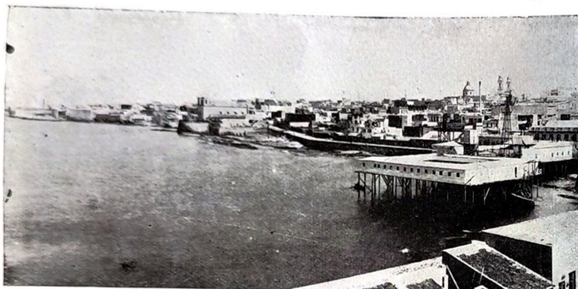
Los baños de Aurquía en plena ciudad congregaban en 1900 a centenares de bañistas
