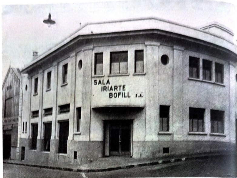
Fachada del nuevo edificio de la calle Piedras enq. B. Mitre y depósito anexo
