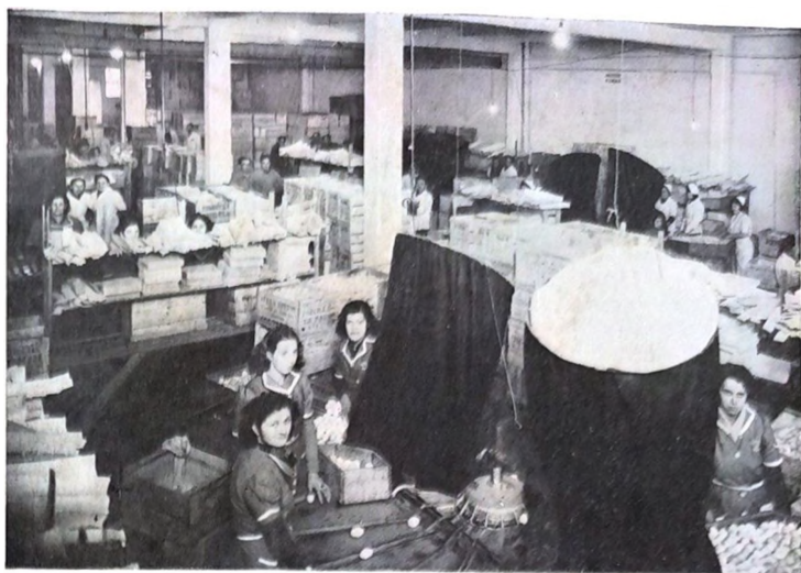
Una de las plantas destinadas a la clasificación de huevos para exportación con 6 máquinas que clasifican 50.000 huevos por hora.
