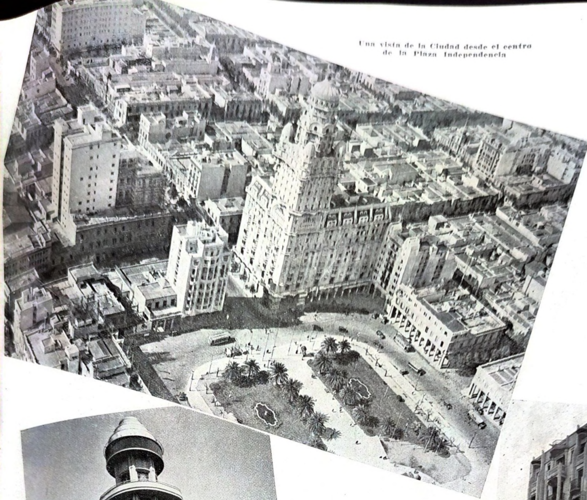
Edificio Av. 18 de Julio y Plaza Independencia
