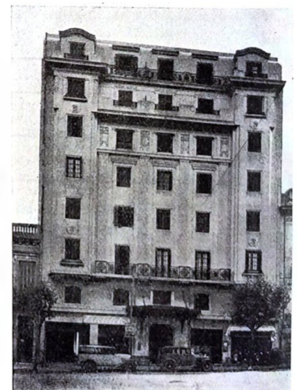
Otro elegante edificio propiedad del Banco, en la calle Constituyente 1955 al 61.
