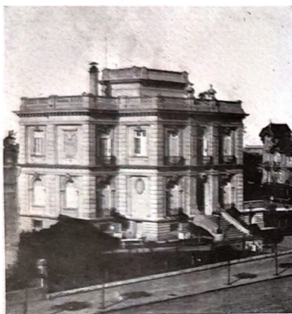
Casa Pietracaprina. Arq. Gardelle
