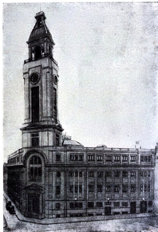
El edificio actual del Correo
