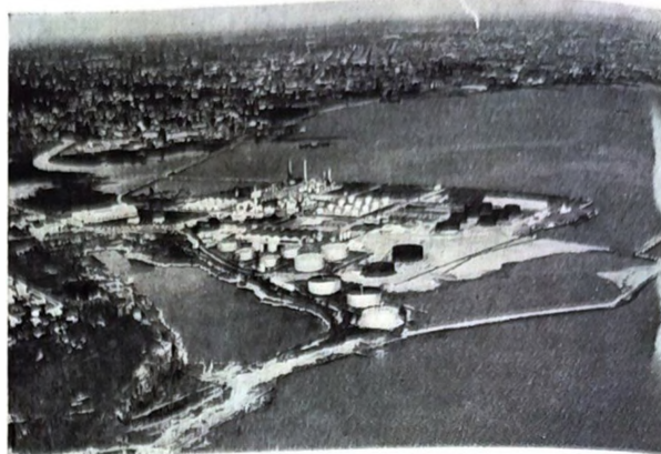
Planta de combustibles. Se destacan los tanques de almacenamiento y el Muelle
