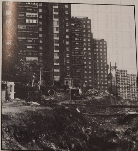
Obras en la Rambla para construir el tramo oeste del interceptor costero.
