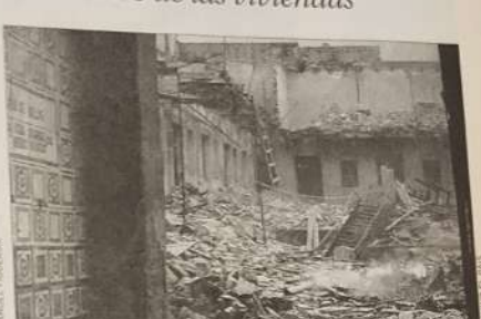
DERRUMBE. Ser monumento histórico no lo salvó de la demolición
