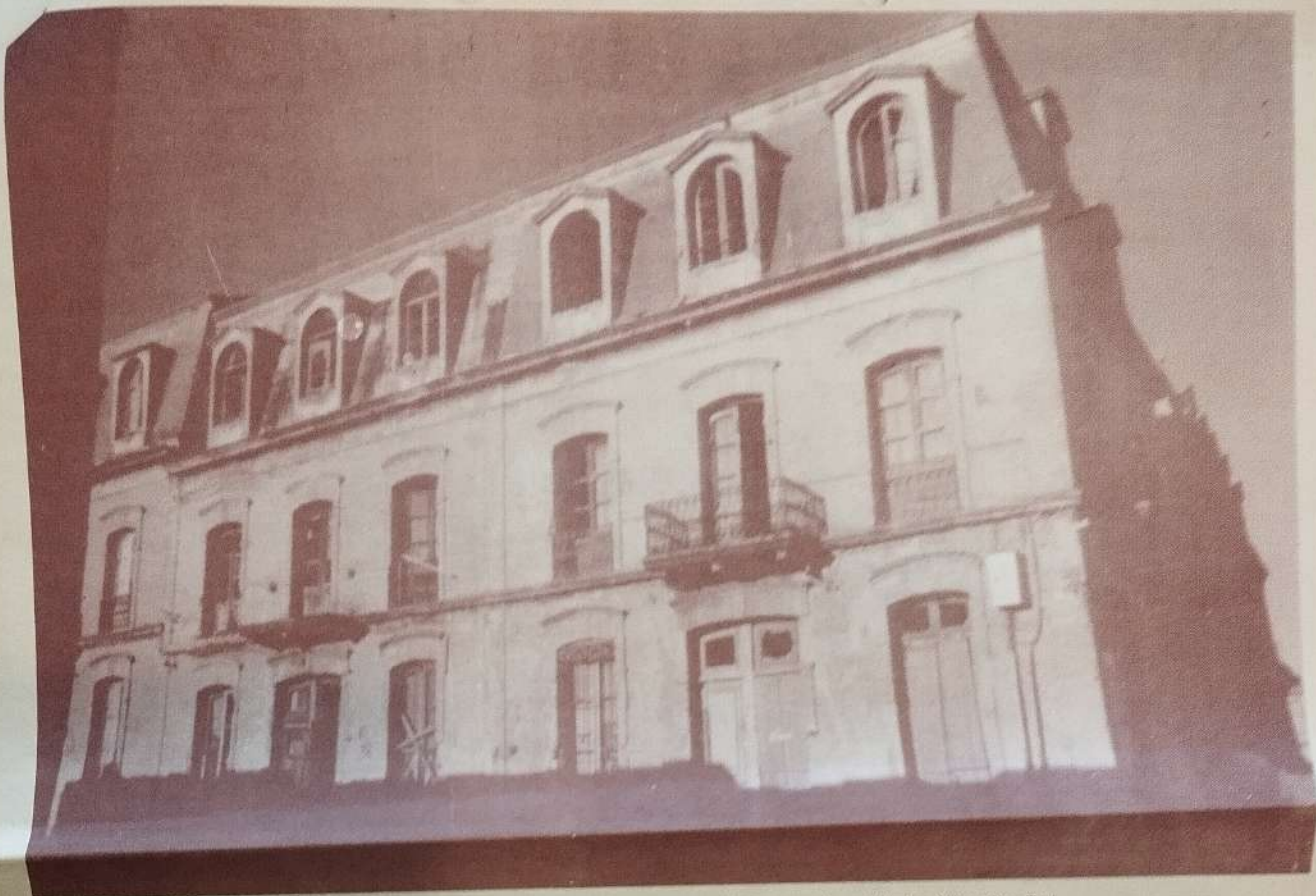
Detalle del sector menos deteriorado del Barrio Reus al Sur, iniciado en 1888 a iniciativa del Dr. Emilio Reus, con el aporte técnico del Arq. Juan Tosi.
