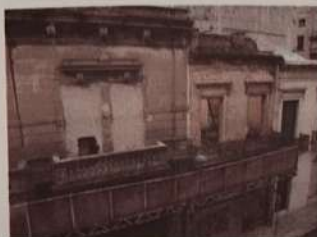
FIGURA 21. ALGUNOS INMUEBLES ABANDONADOS DESDE LARGO TIEMPO ATRÁS SON ACTUALMENTE OCUPADOS EN LAS PEORES CONDICIONES DE HABITABILIDAD. FOTO: J. YOLANDA BORONAT, 2014.
