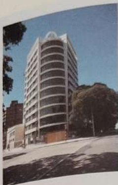
FIGURA 43. TEE TOWER (EN CONSTRUCCIÓN) UBICADA EN EL BARRIO PUNTA CARRETAS, EN LA ESQUINA DE BULEVAR GENERAL ARTIGAS Y CALLE SOLANO GARCÍA, FRENTE AL CLUB DE GOLF. LA PUBLICIDAD PARA LA VENTA DE LOS APARTAMENTOS DESTACA: «UBICADO SOBRE LA AUTÉNTICA PRIMERA FILA DE MONTEVIDEO, CON VISTAS PANORÁMICA HACIA PUNTA CARRETAS Y PARQUE RODÓ». FOTO: TATIANA RIMBAUD, 2014.
