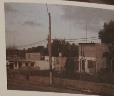
FIGURA 99. VIVIENDAS CONSTRUÍDAS DE MODO INFORMAL AL FONDO DE UN PREDIO PROPIEDAD PRIVADA DEL CATRASTO FORMAL. FOTO, EQUIPO REAHVI.
