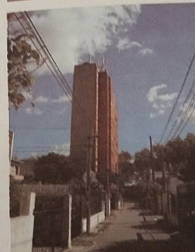
FIGURAS 77 Y 78. EDIFICIO EN CALLE FRAY BENTOS CASI COMERCIO E IMAGEN DE LA MISMA CALLE A POCOS METROS DEL EDIFICIO. FOTOS: J. YOLANDA BORONAT, 2015.
