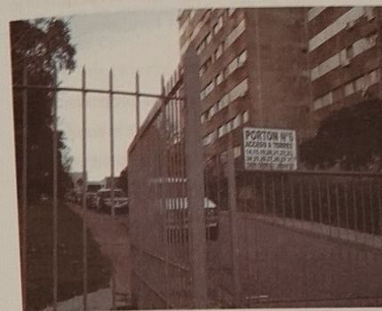
FIGURA 109. PORTÓN n.º 6 DE ACCESO AL CONJUNTO HABITACIONAL EUSKALERRÍA 70. LAS CALLES ANTES DE USO PÚBLICO LIBRE, ACTUALMENTE ES DE USO EXCLUSIVO PARA LOS RESIDENTES DEL CONJUNTO Y QUIENES SON AUTORIZADOS A INGRESAR. REJAS Y PORTONES VIGILADOS SEPARAN FRAGMENTOS URBANOS, INCLUSO ALLÍ DONDE RESIDE POBLACIÓN DE UN MISMO NIVEL SOCIOECONÓMICO, EN SOLUCIONES HABITACIONALES QUE FUERON REALIZADA EN EL MARCO DE PROGRAMAS DE VIVIENDA DE INTERÉS SOCIAL. FOTO: J. YOLANDA BORONAT, 2015.
