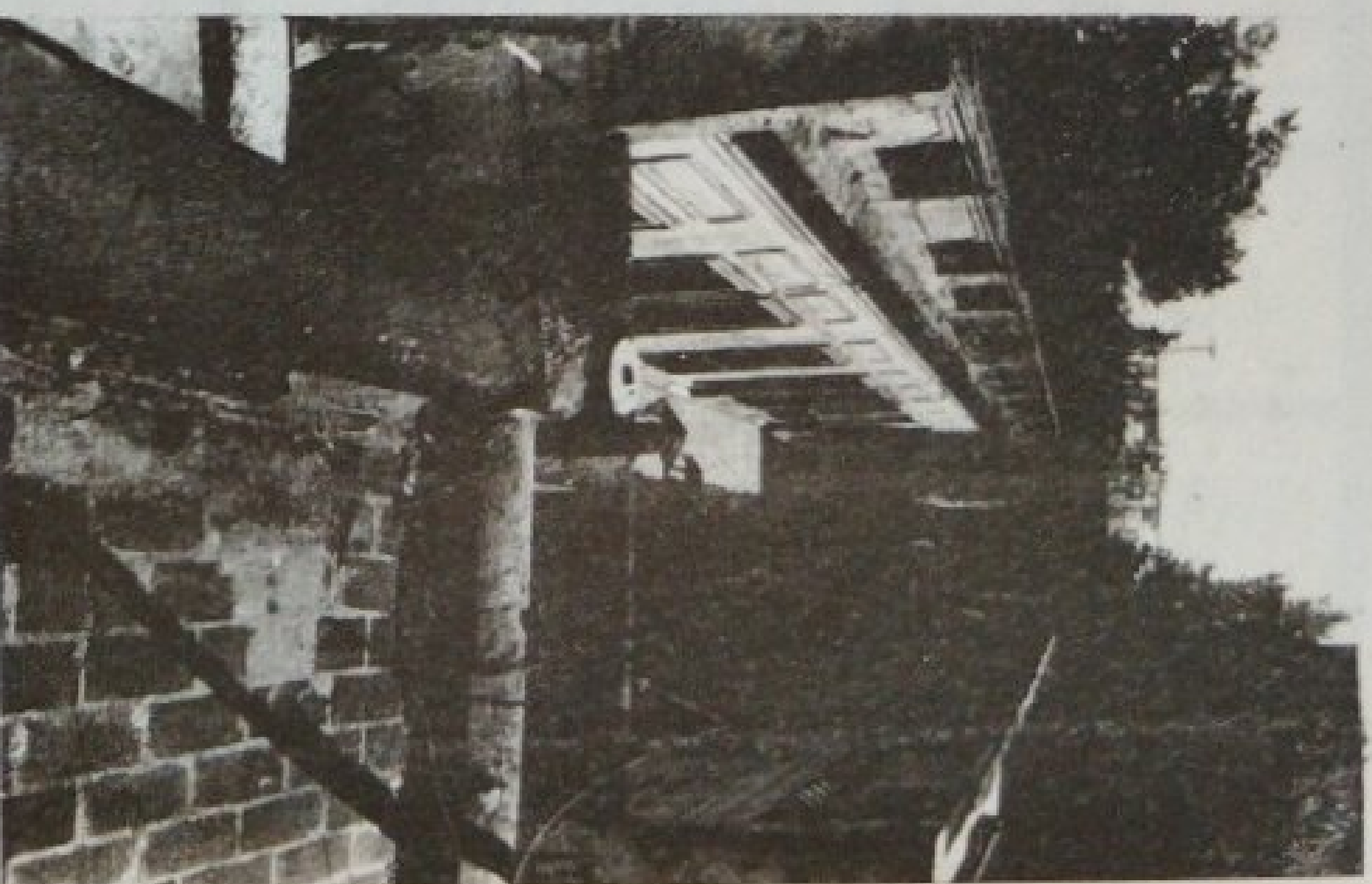
Calle interior vista desde la azotea de una vivienda sobre la calle Guatemala.
