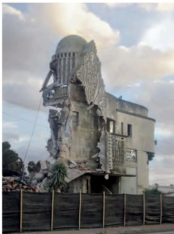
Demolición del edificio Assimakos. Enero de 2014.
