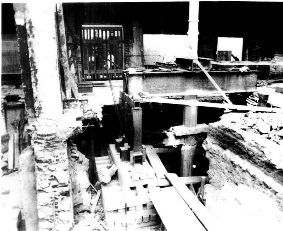
Abajo: el apuntalamiento y el recalce de la estructura
