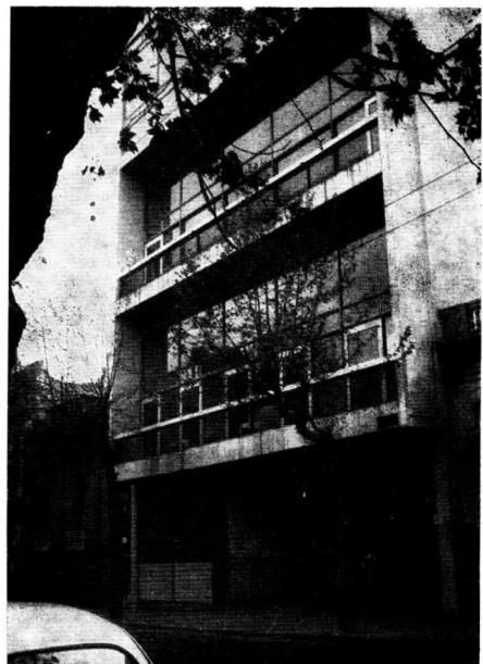
EDIFICIO CENTRO PROTECCION DE CHOFERES Arqts. BISOGNO, GILBOA, REVERDITO RODRIGUEZ JUANOTENA
