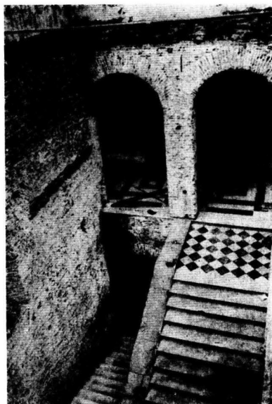
Caja de escaleras
