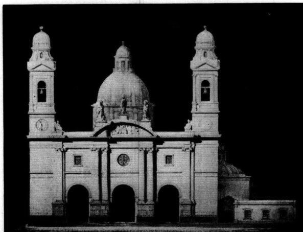
VISTA DE LA FACHADA como queda actualmente
