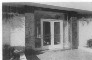
Detalle entrada. Edificio Salvo
