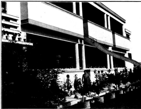
Pabellón "B", - Vista 7
