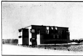
Pabellón B. — Vista 6
