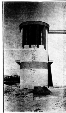
Pabellón B. — Vista 1
