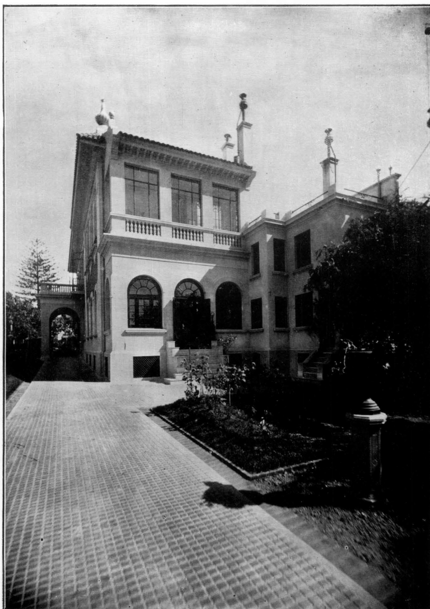
FACHADA POSTERIOR DEL EDIFICIO
