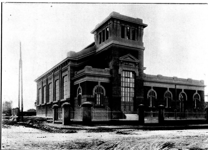
Edificio de la Usina Eléctrica de la ciudad de Maldonado
