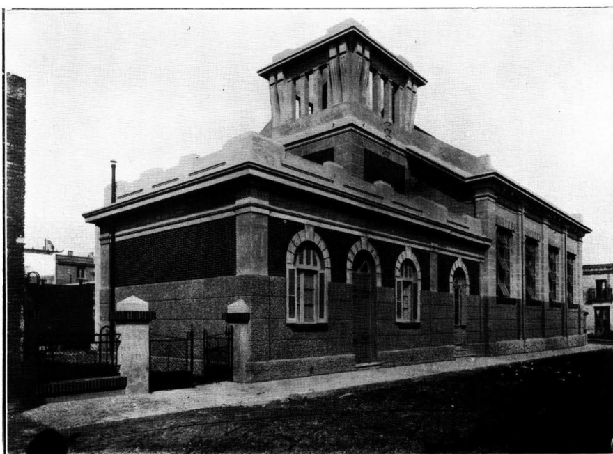
Edificio de la Usina Eléctrica de Canelones
