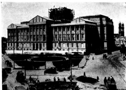
VISTA DEL PALACIO EN CONSTRUCCIÓN
