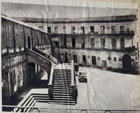
La monumental escalera posterior, hace unos años, cuando ya se había demolido parte del edificio y defendido con perlasas el interior del Mercado de la feria de las pampas.
